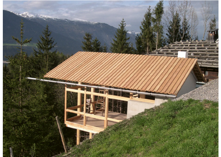
Errichtung des Zubaus (Veranda) 2005
