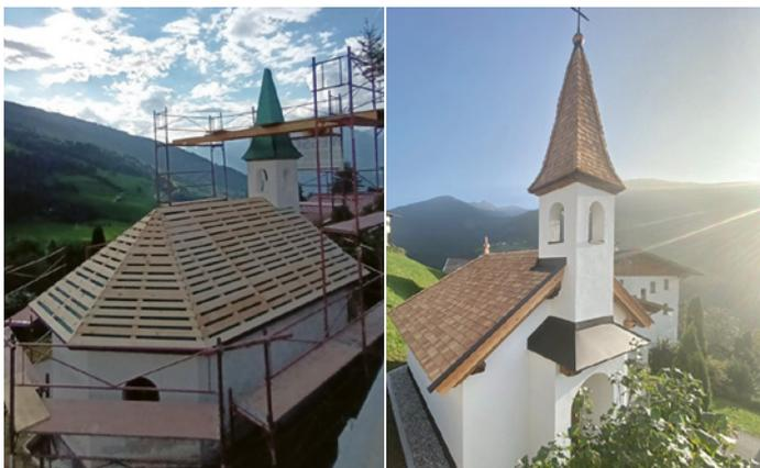
Die verfaulten Schindeln wurden durch neue ersetzt und die bröckelnde Fassade neu verputzt. Alles begann am 1. September 2023, da wurde das alte Dach abgetragen. Mit viel Motivation ging es alle Tage Schritt für Schritt voran, sodass nach vielen Arbeitsstunden die Renovierungszeit nach nur einem Monat zu Ende ging. Der Hobbyclub Berghof freut sich riesig, so ein Objekt in Ehren halten zu dürfen.
